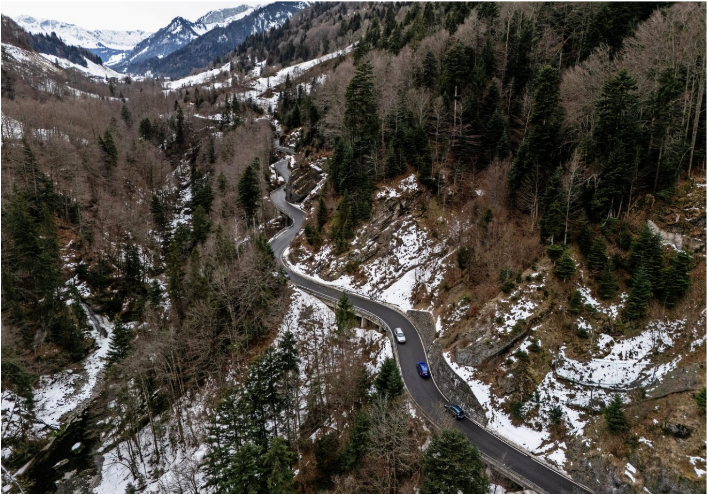
So sieht die Kantonsstrasse zwischen Under Lammburg und Under Tendli heute aus.
